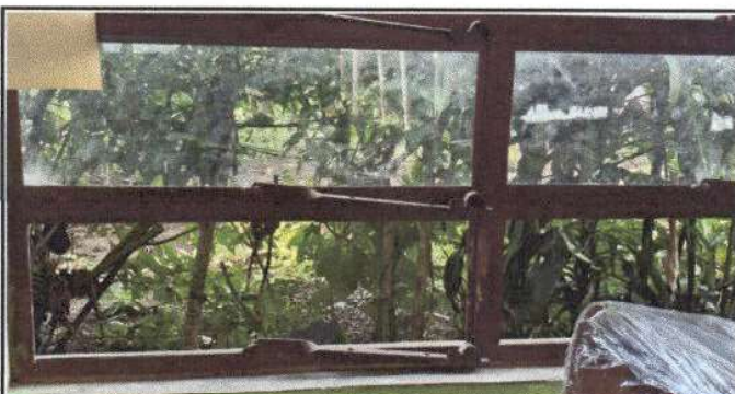
Foto 3: MÓDULO 1 AULAS VENTANAS: Sustitución de vidrios
