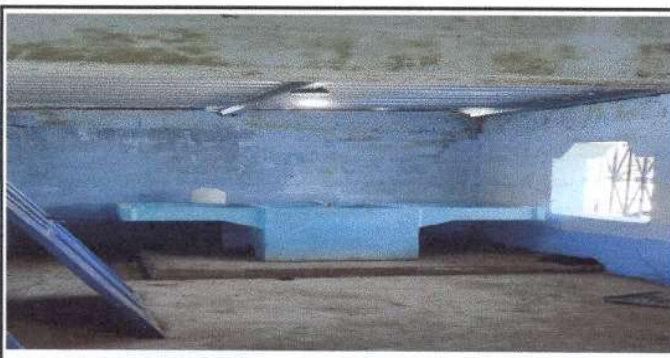
Foto 11: MÓDULO 3 COCINA: REPARACIÓN DE COCINA: Sustitución de pila de cemento de dos lavadero
