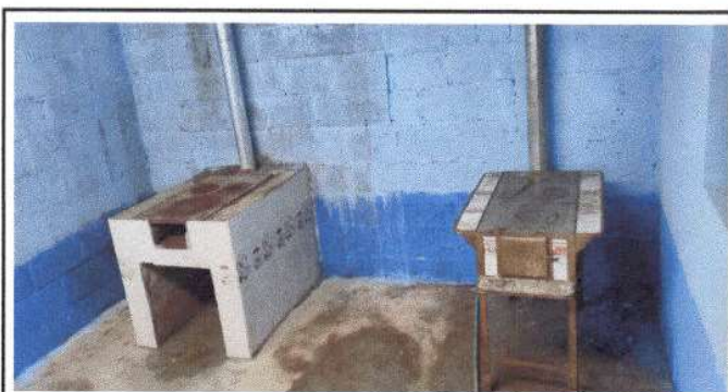
Foto 10: MÓDULO 3 COCINA: REPARACIÓN DE COCINA: Sustitución de estufa rural (completa) incluye chimenea y plancha de metal
