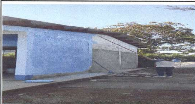
Foto 1: MÓDULO 1 AULAS CUBIERTA DE LÁMINA: Sustitución de lámina, por lámina troquelada aluzinc calibre 26
