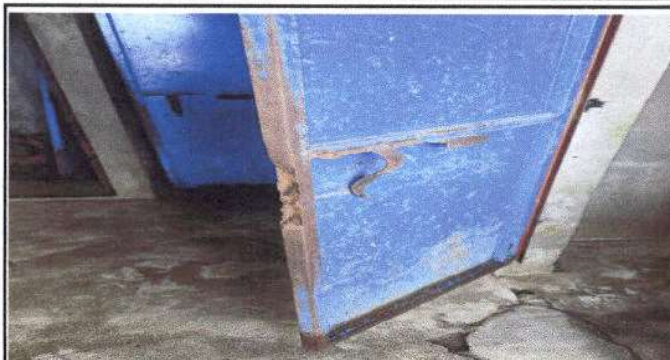
Foto 2: MÓDULO 1 AULAS PUERTAS DE METAL: Mantenimiento a estructura (lijado, cambio de tubo , cepillado, sujeciones, aplicación de pintura); Sustitución de chapa
