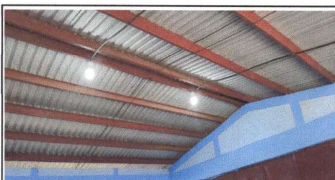
Foto 4: MÓDULO 1 AULAS REPARACION DE SISTEMA ELÉCTRICO: Sustitución de tomacorrientes dobles; Sustitución de tablero de flípones; Reparación de cableado eléctrico
