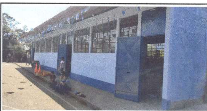
Foto 12: MÓDULO 1 AULAS PINTURA EN MUROS EXTERIORES E INTERIORES: Pintura en muros exteriores e interiores
