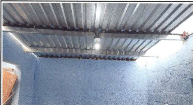
Foto 7: MÓDULO 3 COCINA: CUBIERTA DE LÁMINA: Sustitución de lámina, por lámina troquelada aluzinc calibre 26
