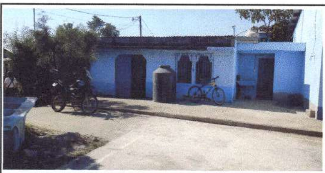
Foto 5: MÓDULO 2 SERVICIOS SANITARIOS: Mantenimiento a estructura (lijado, cambio de tubo , cepillado, sujeciones, aplicación de pintura) a puertas servicios sanitarios
